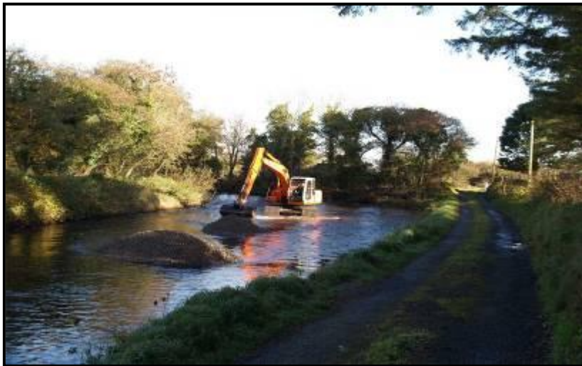
Figiúr 9. Gairbhéal sceathraí á thabhairt isteach agus á scaipeadh in Abhainn Chluanach Mór (Baile Phámar, Maigh Eo)
