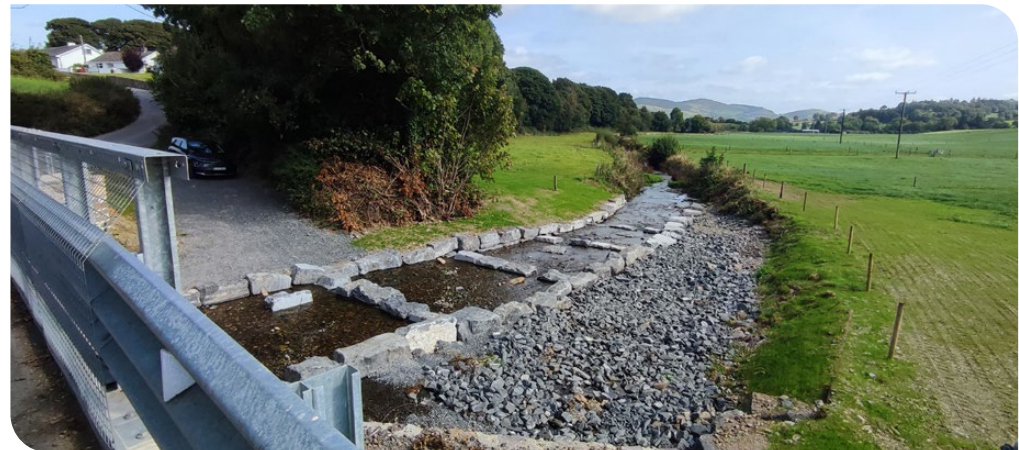
Íomhá: Droichead i dTeampall Doire, Contae Thiobraid Árann, grianghraf i ndiaidh na n-oibreacha de rampa carraige nua bealaigh éisc.
