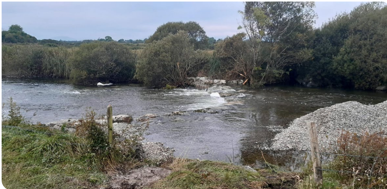
Íomhá: Cora cloiche athmhúnlaithe ina stua in aghaidh srutha agus gairbhéal scéachtana le hathdháileadh suas an abhainn.
