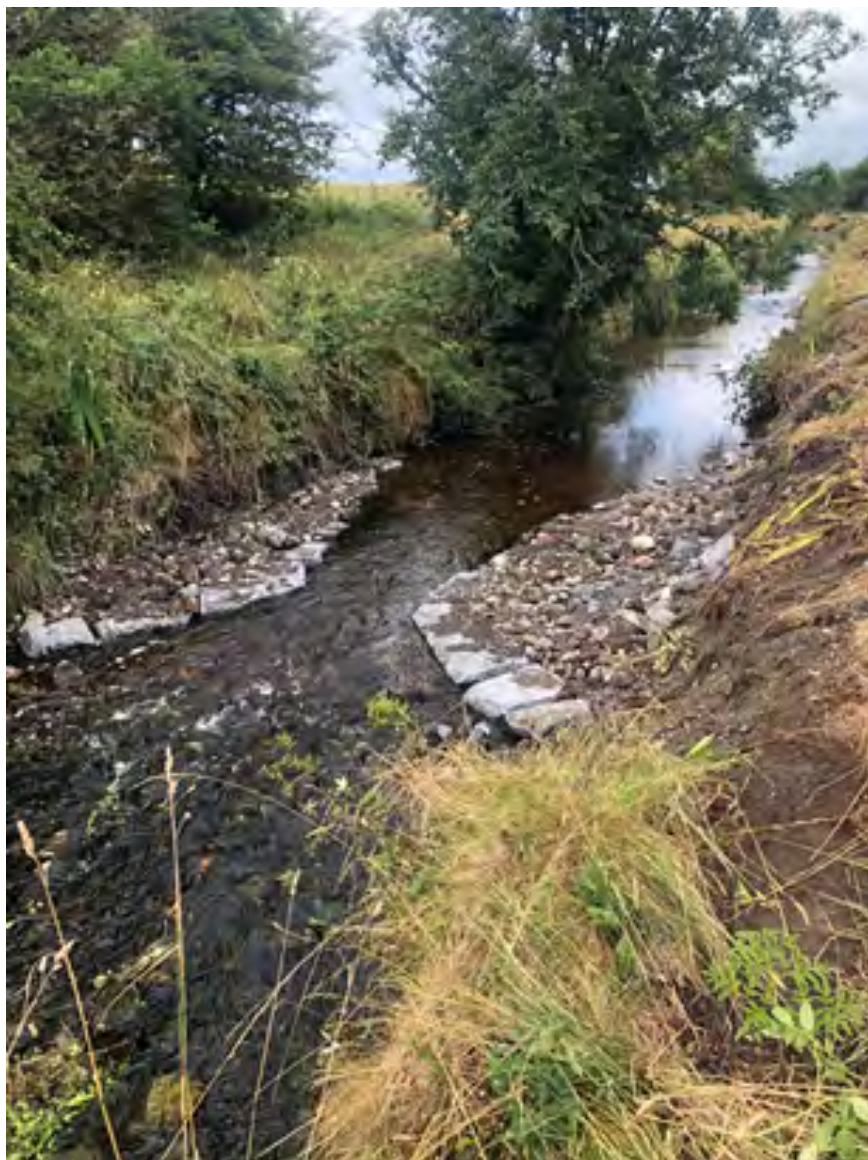
Fíor 9.1 Athchóiriú Gnáthóg Cuidíonn struchtúir, amhail na sraonairí péireáilte seo, le sreafaí a athrú agus coinníollacha hidreolaíocha níos éagsúla a chruthú in aibhneacha atá draenáilte go hartaireach. Déanann sé seo cainéil a mionathraíodh go láidir
